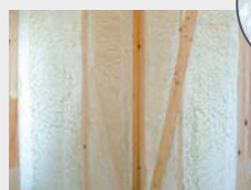
壁に吹き付け (面材)
